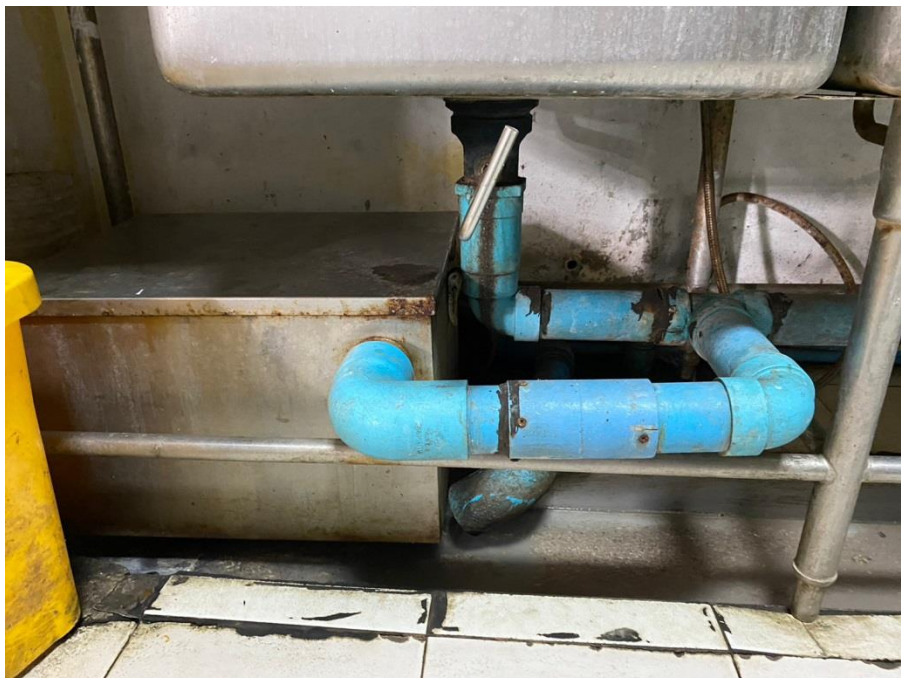
ภาพที่ 30 แสดงถึงดักไขมันเบื้องต้นภายในห้องครัว
