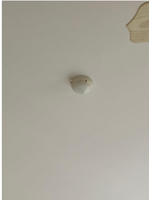
ภาพที่ 7 แสดง Heat Detector ภายในห้องพัก
